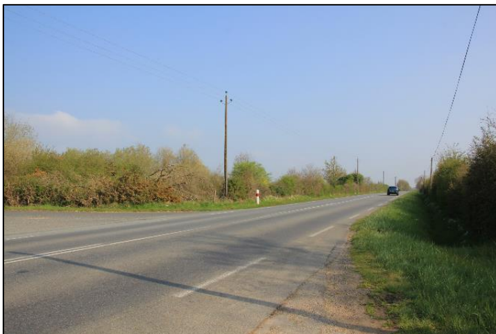
Intersection au niveau de la RD938 (vue vers le nord)
